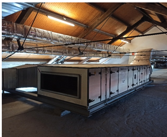
Figura 51. Climatitzador de golfes 1.
