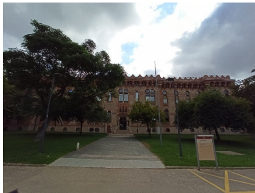
Figura 41. Façana sud del Pavelló Mestral.
